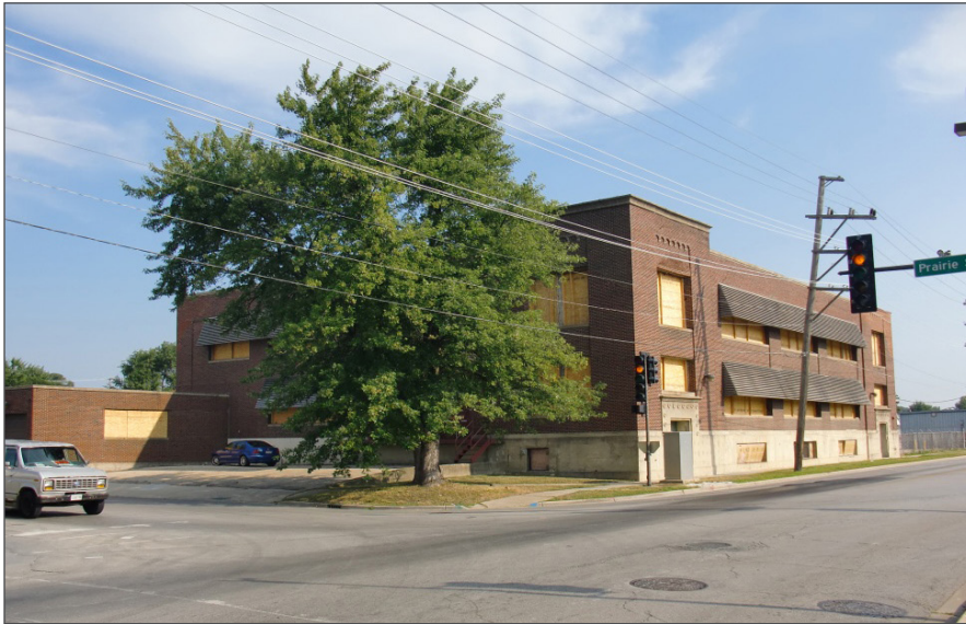
edificio afectado (arriba)
